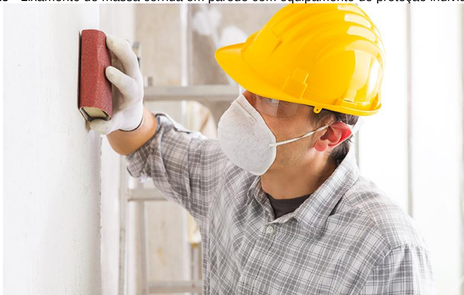
Figura 25 - Lixamento de massa corrida em parede com equipamento de proteção individual (EPI)
