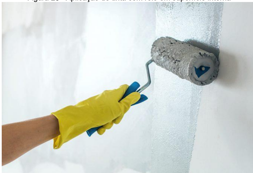
Figura 28 - Aplicação de tinta com rolo em superfície interna
