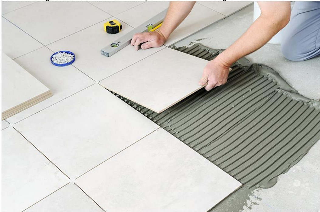
Figura 19 - Assentamento de piso cerâmico com argamassa colante
