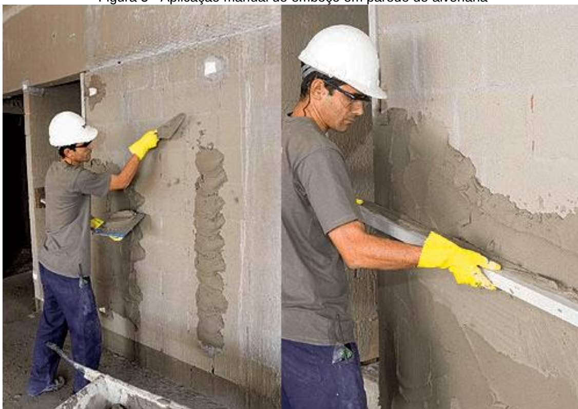
Figura 5 - Aplicação manual de emboço em parede de alvenaria
