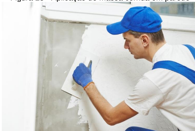
Figura 23 - Aplicação de massa corrida em parede
