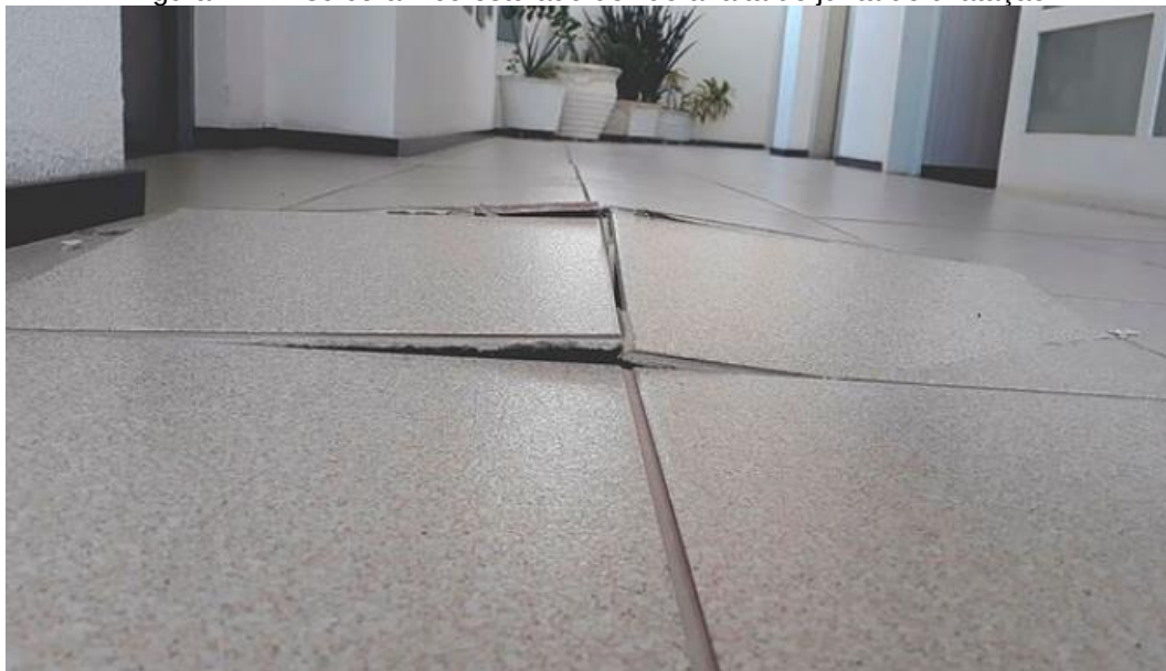
Figura 22 - Piso cerâmico estufado devido à falta de junta de dilatação
