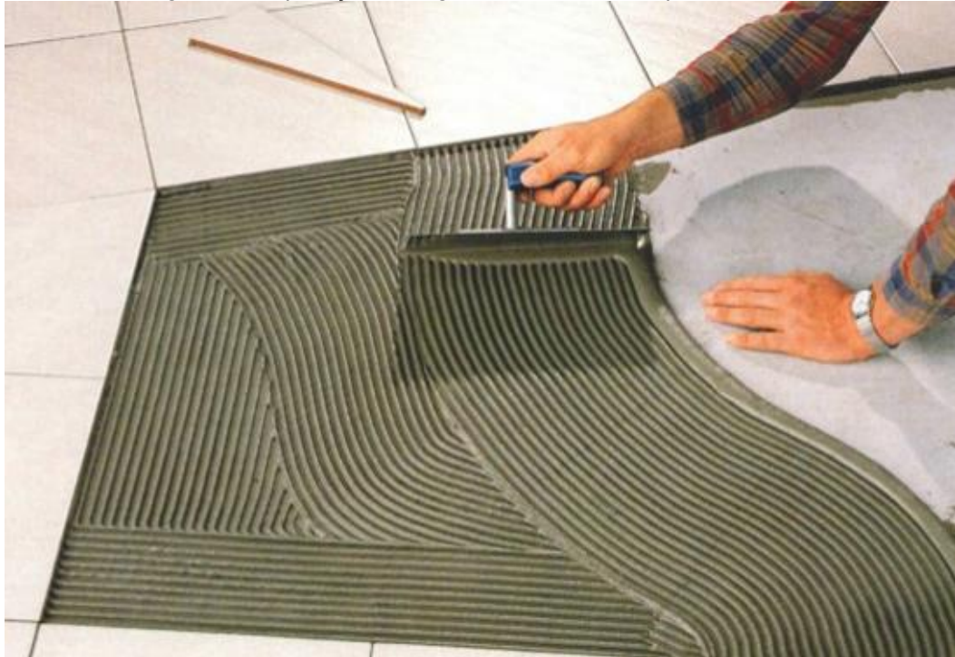
Figura 18 - Aplicação de argamassa colante em piso cerâmico
