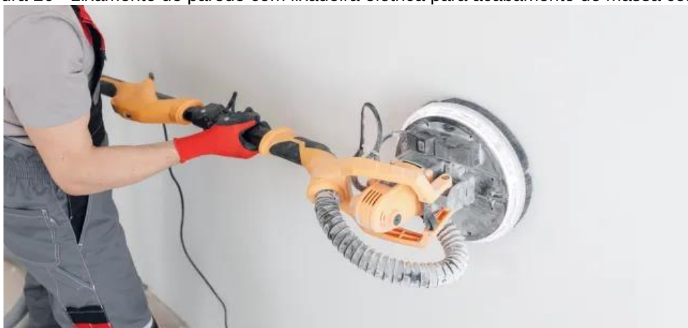
Figura 26 - Lixamento de parede com lixadeira elétrica para acabamento de massa corrida
