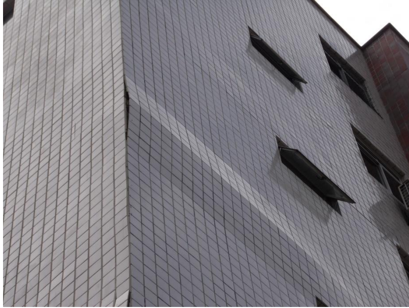
Figura 21 - Problemas de descolamento em fachada com revestimento cerâmico
