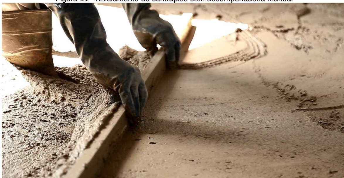
Figura 11 - Nivelamento de contrapiso com desempenadeira manual
