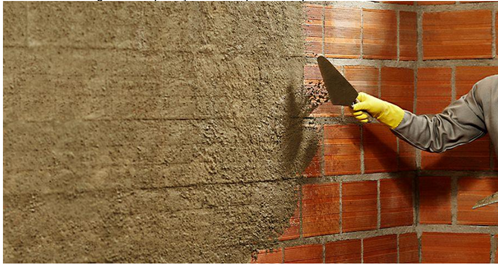
Figura 3 - Aplicação de chapisco em parede de alvenaria
