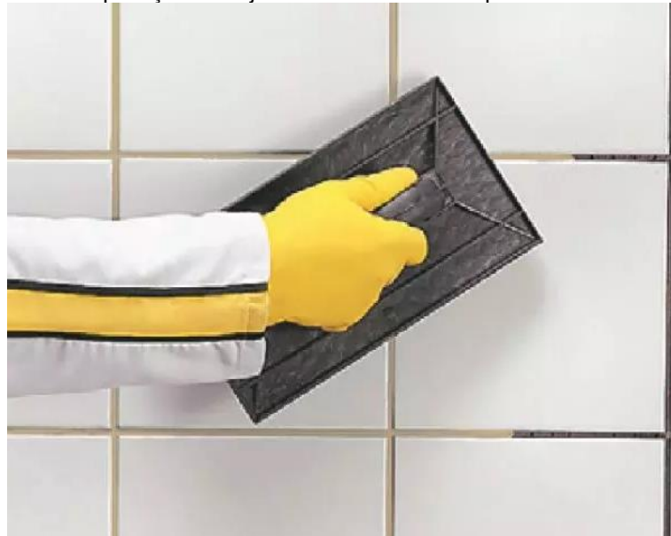
Figura 16 - Aplicação de rejunte utilizando desempenadeira de borracha
