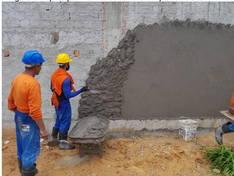
Figura 8 - Aplicação manual de reboco em parede de alvenaria
