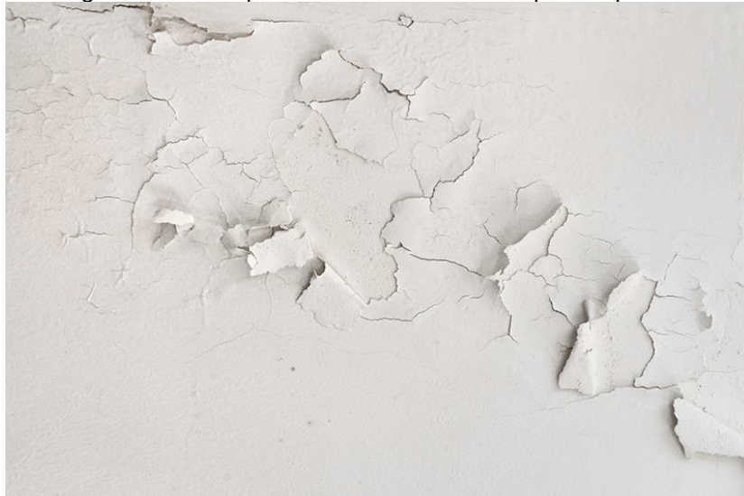
Figura 30 - Exemplo de descascamento em parede pintada
