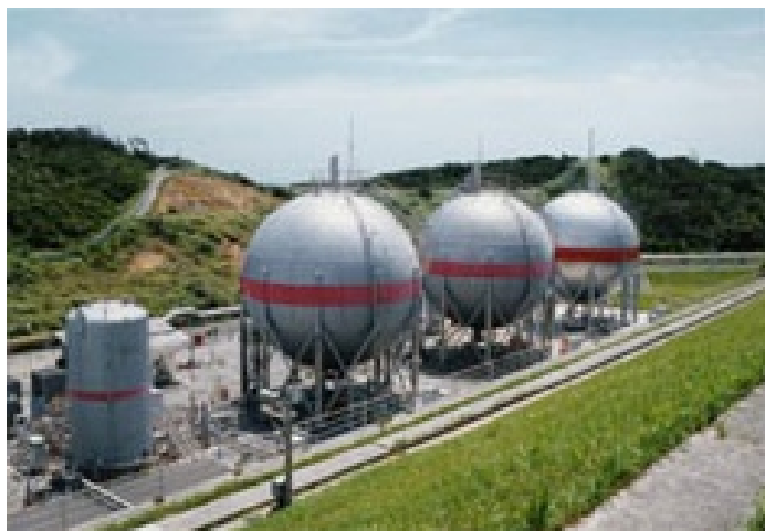
Figura 1.3 – Tanques esféricos para armazenamento de hidrogênio
