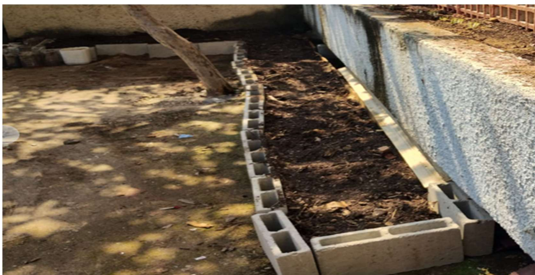
Figura 21 – Montagem do canteiro da turma 151
