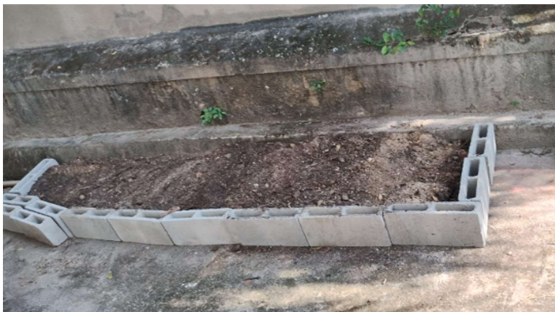
Figura 15 – Montagem do canteiro da turma 162
