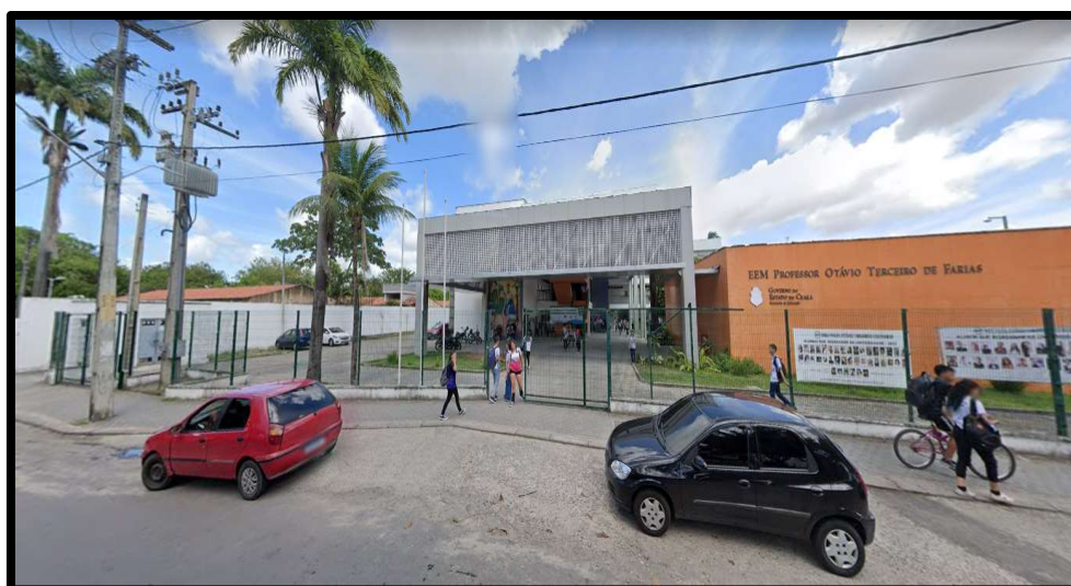
Figura 4 - Fachada da escola
