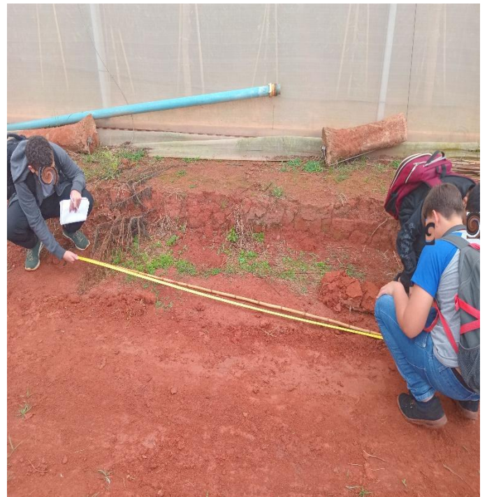
Foto 8 – Preparação para traçado das medidas da estufa
