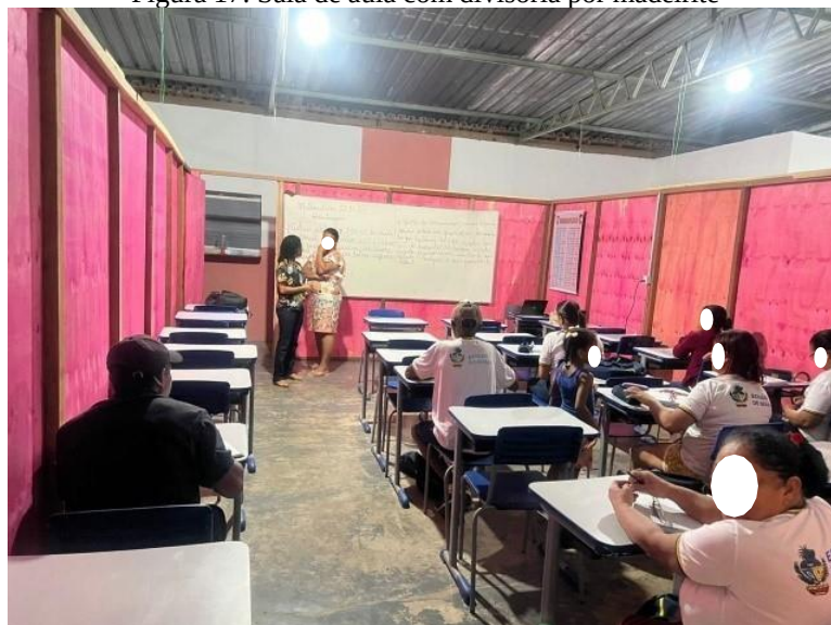
Figura 17: Sala de aula com divisória por madeirite
