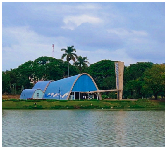
Figura 2 – Facciata laterale della Chiesa di San Francesco d'Assisi
