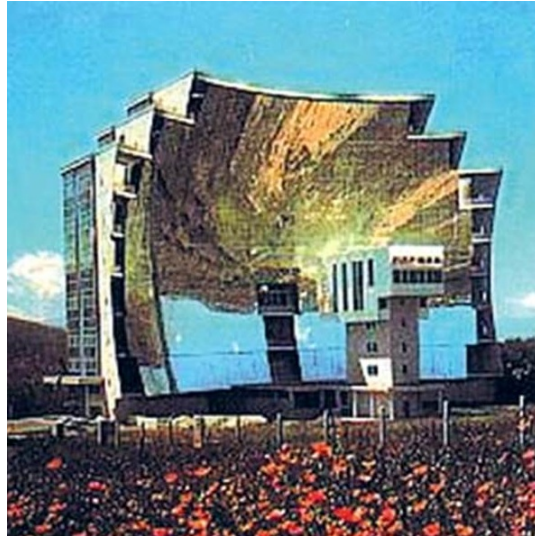
Figura 40: Captadores de energia solar
