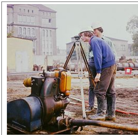
Figura 3.2: Nivelamento de uma construção moderna
