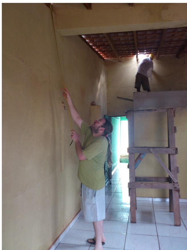
Figura 2.13: Coletando medidas para cálculo da inclinação do telhado II
