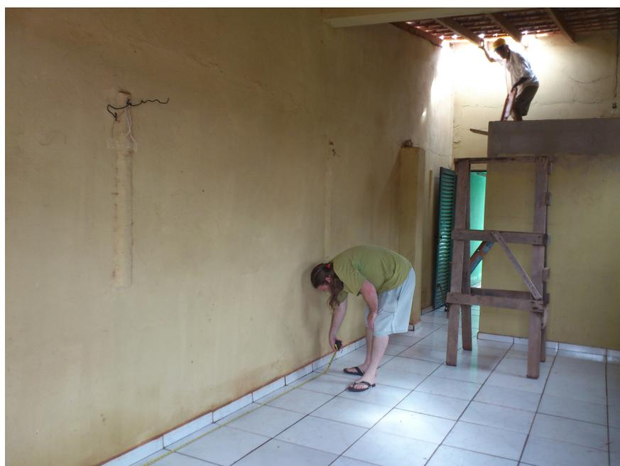
Figura 2.14: Coletando medidas para cálculo da inclinação do telhado III
