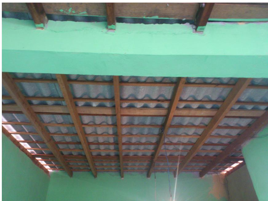
Figura 2.18: Vista interna do telhado depois de trocada as telhas
