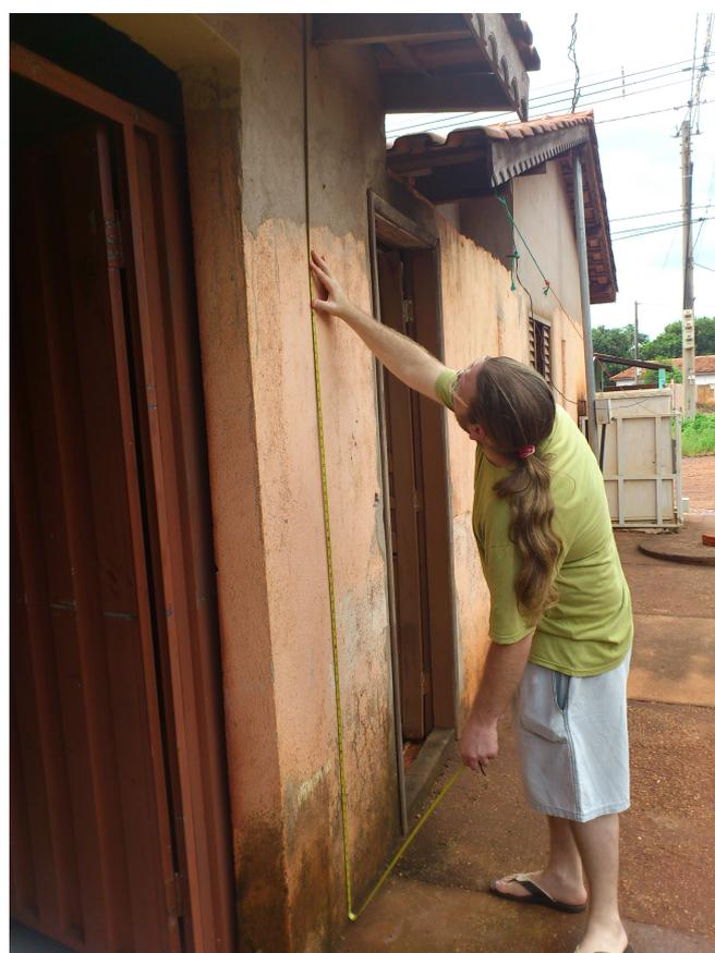
Figura 2.12: Coletando medidas para cálculo da inclinação do telhado I
