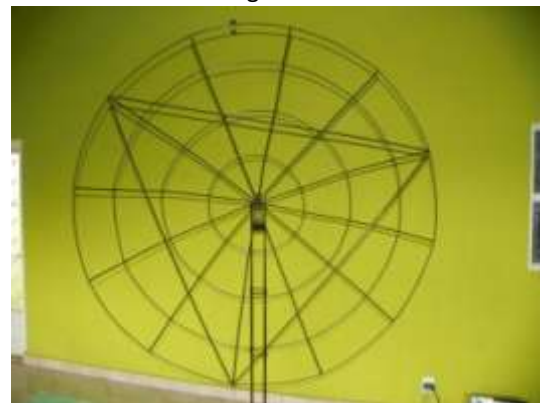
Foto armação da calota elipsoide Figura 67.
