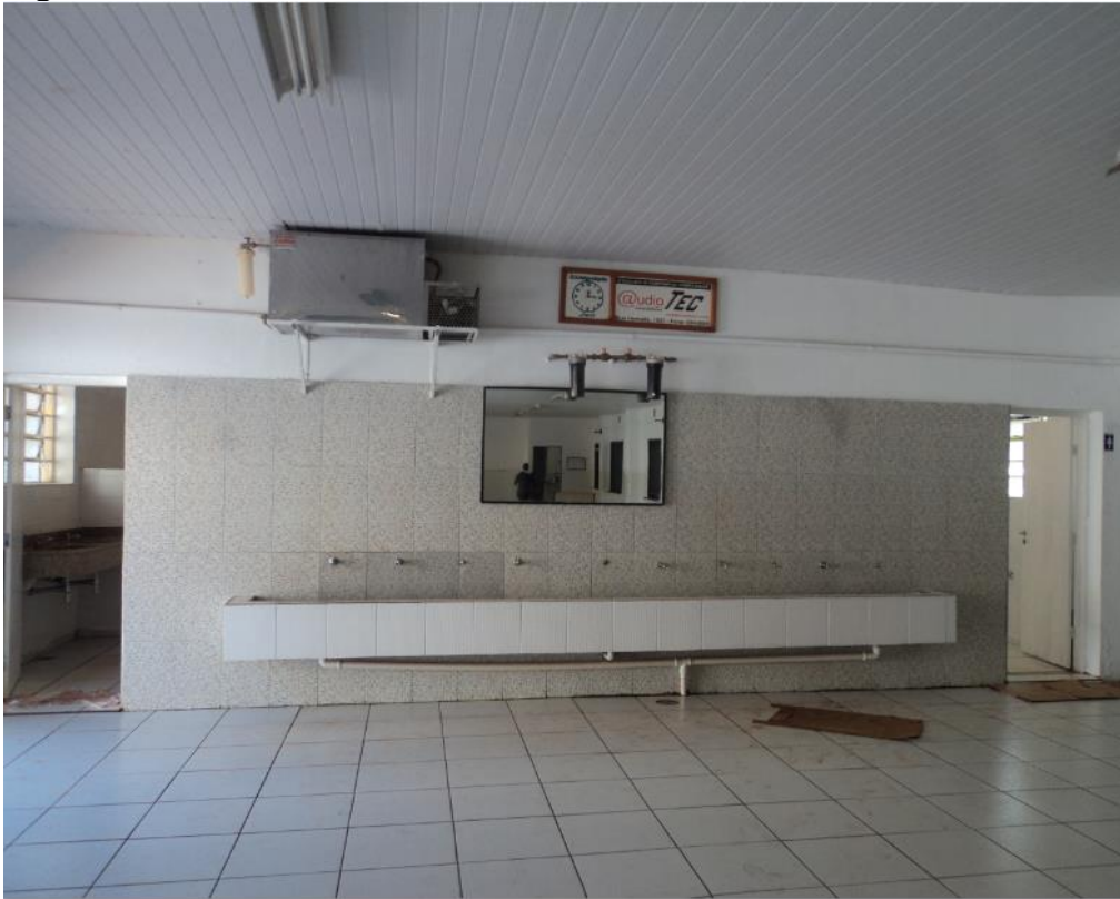
Figura 3: Pátio da escola - sanitários e bebedouro
