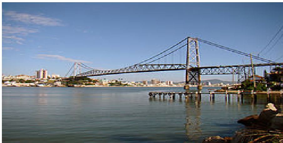
Figura 11 – Ponte Hercílio Luz
