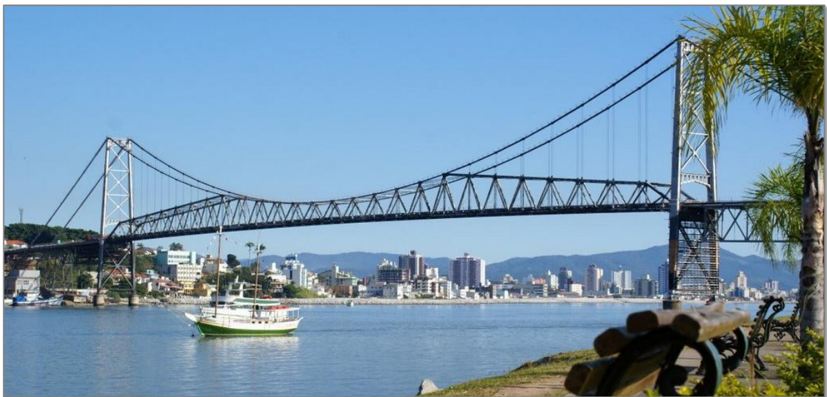
Figura 22 – Ponte Hercílio Luz
