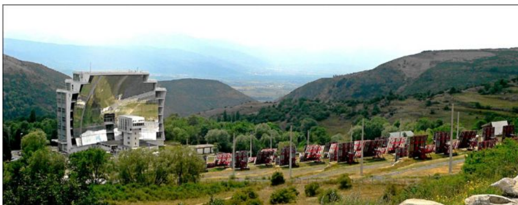
Figura 106 – Coletor solar de Odeillo
