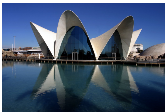
Figura 116 – Estrutura em forma de parabolóide hiperbólico
