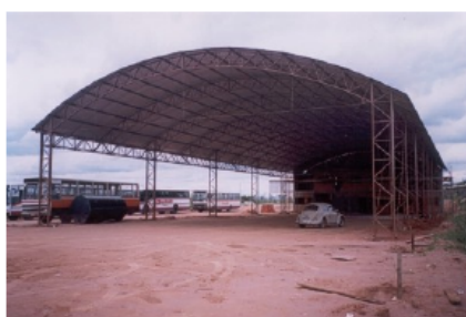
(c) Cobertura metálica (galpão)
