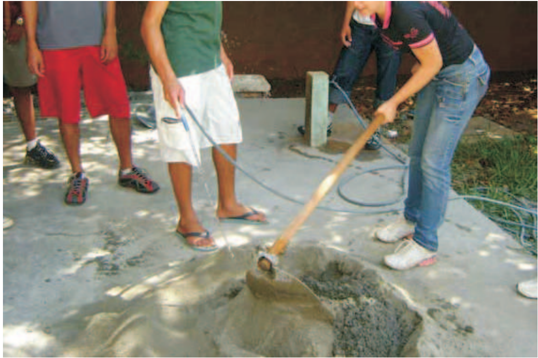
Figura 8.3 Alunos preparando a massa de concreto
