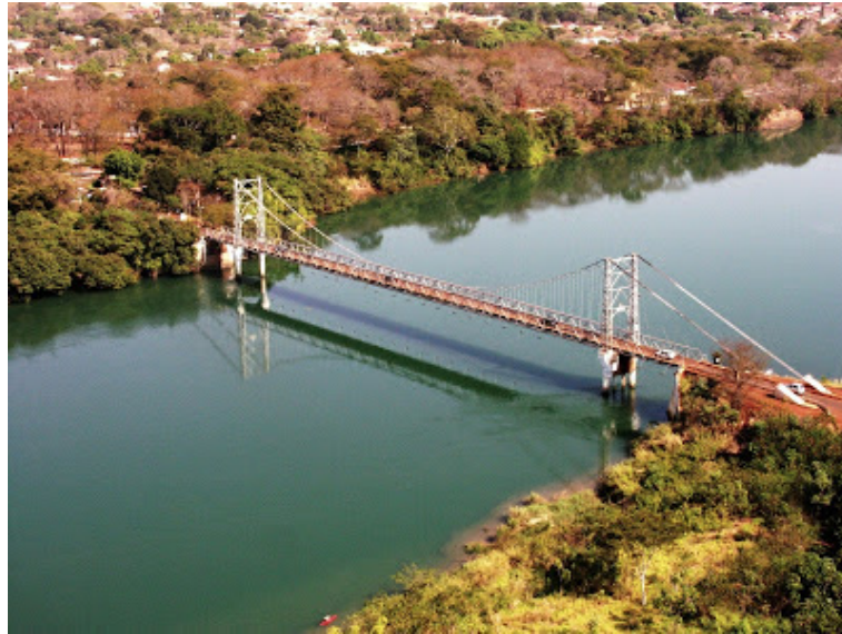
Figura 32 – Ponte Affonso Penna
