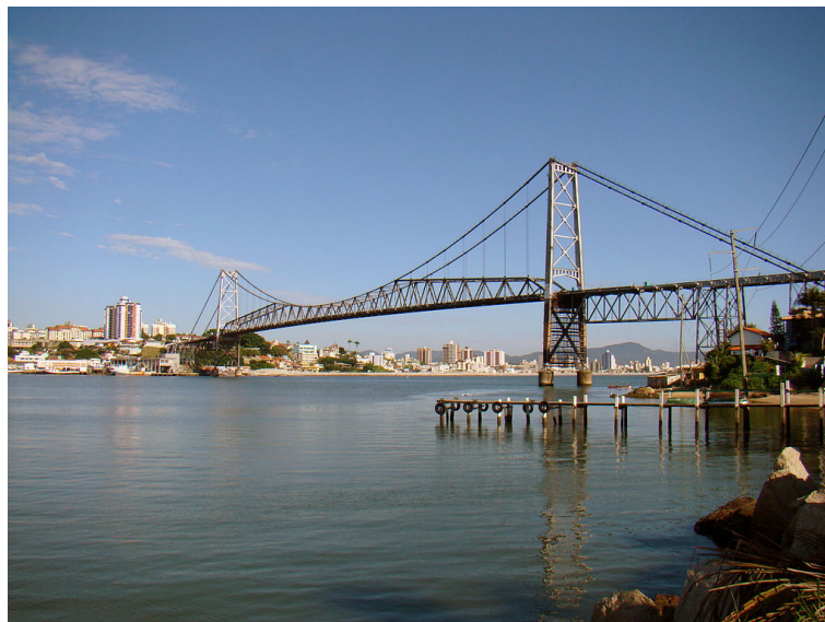
Figura 34 – Ponte Hercílio Luz
