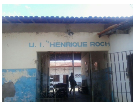
Figura 3.2: Fachada da Unidade Integrada Henrique Rocha.
