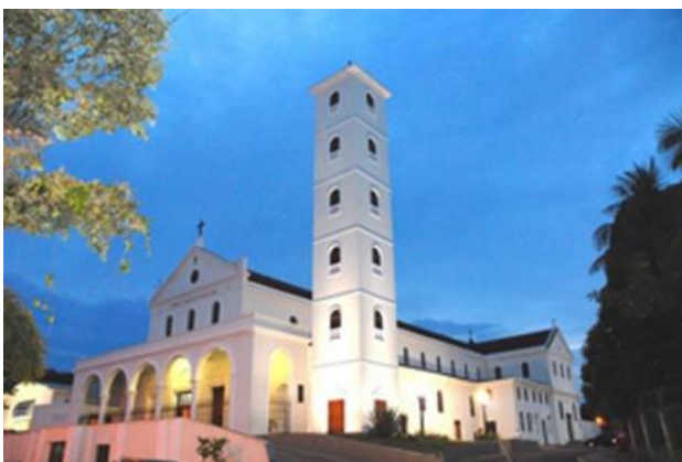
Figura 4.1.6: Torre da Catedral de Rio Branco Acre.
