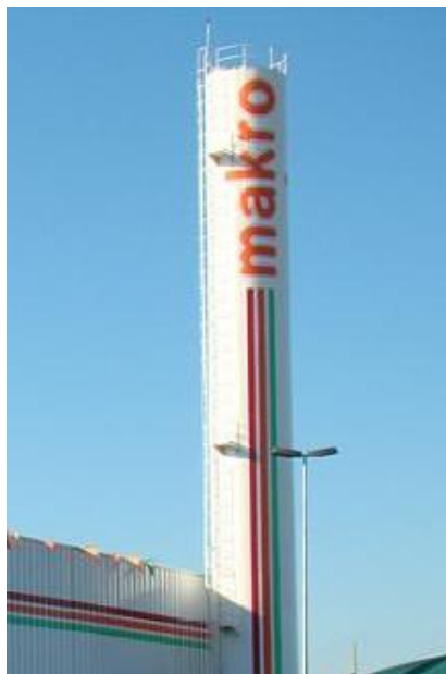
Figura 4.3.1: Reservatório de água do supermercado Makro em Rio Branco, Acre.
