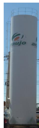
Figura 4.3.4: Reservatório de água do Supermercado Araújo da Estrada do Amapá em Rio Branco, Acre.
