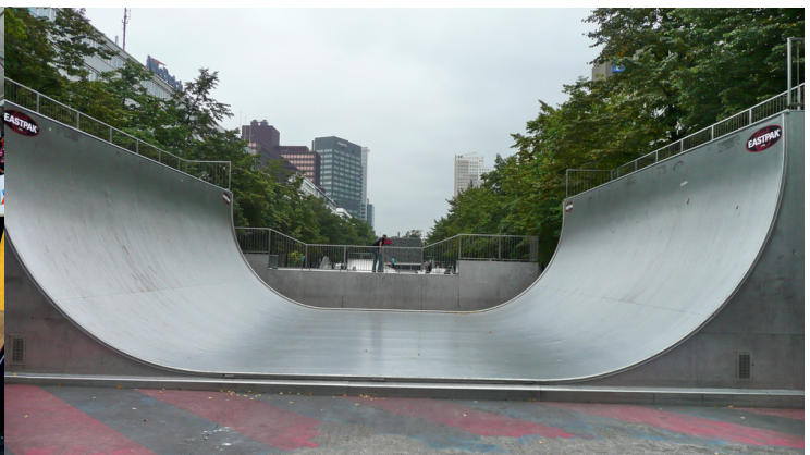
Figura 3.9: Half de concreto.
