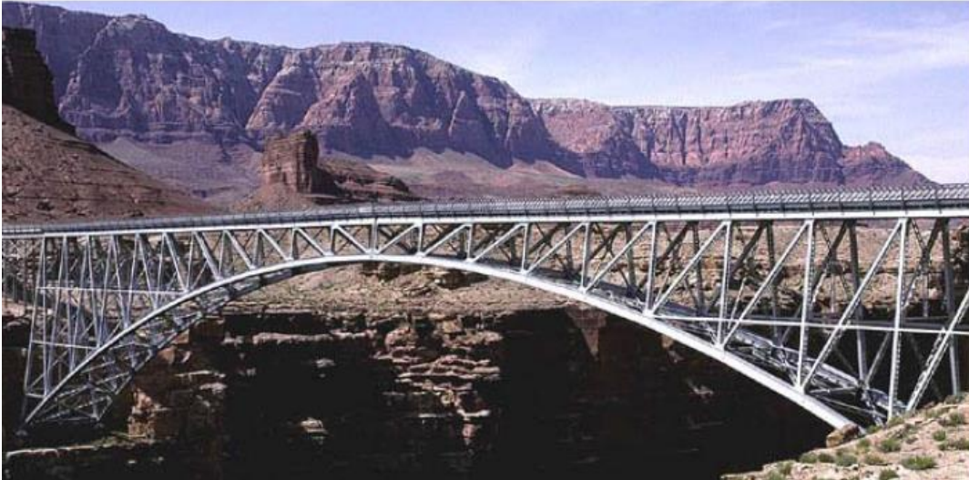
Figura 2.8 Ponte Navajo, Marble Canyon, Arizona, EUA.
