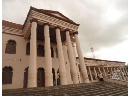
Figura 59 – Vista frontal da fachada da escola
