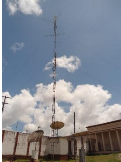
Figura 68 – Torre de transmissão de TV
