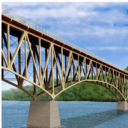
Figura 4.1: Modelo de ponte treliçada [18].
