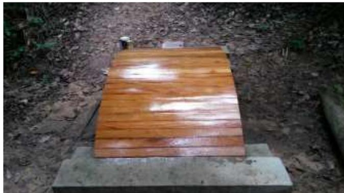
Figura 117 – Vista Superior após aplicação de Verniz
