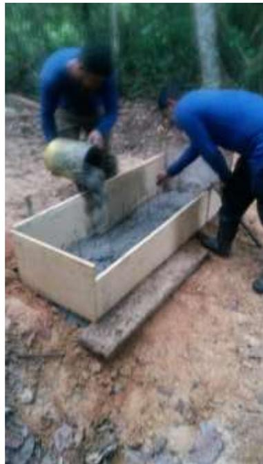
Figura 82 – Lançamento do concreto na Fôrma do primeiro bloco
