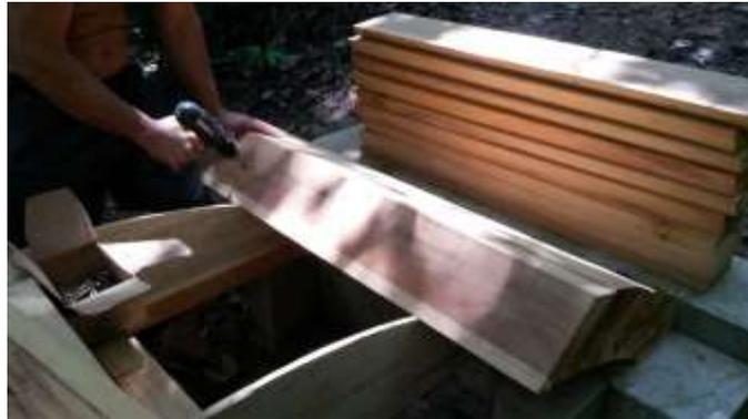
Figura 113 – Colocação de dois Parafusos nas Peças
