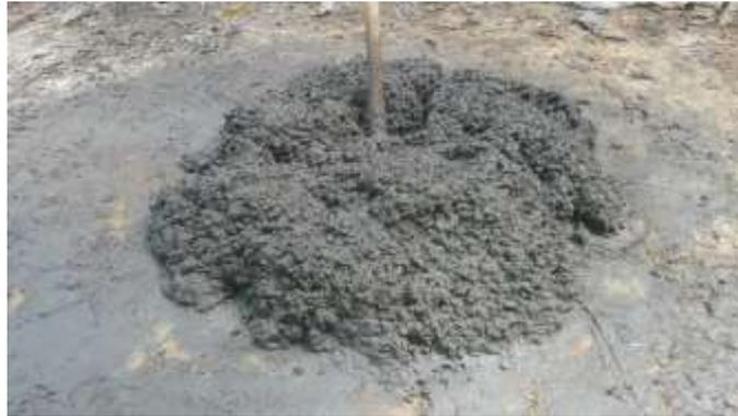
Figura 81 – Concreto pronto para lançamento
