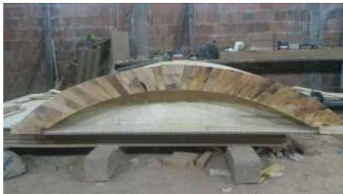
Figura 102 – Peças lapidadas apoiadas em fôrma de madeira
