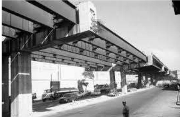
Figura 14 - Estrutura em vigamento múltiplo
