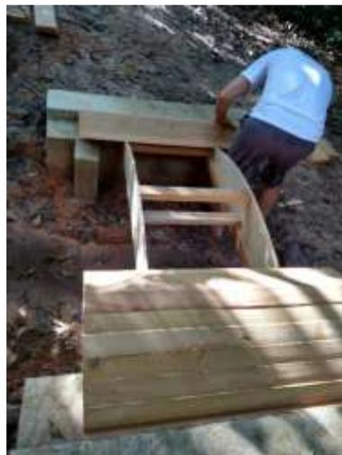
Figura 108 – Montagem das peças na fôrma
