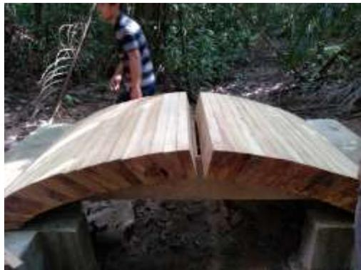
Figura 111 – Montagem das Peças na fôrma
