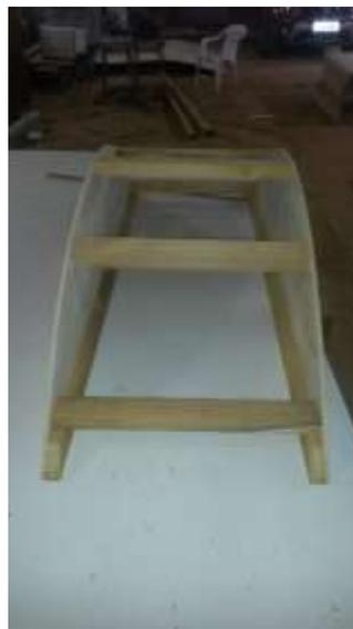
Figura 99 – Estruturação da Fôrma
