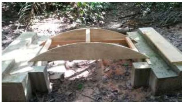
Figura 106 – Fôrma apoiada na base de concreto
