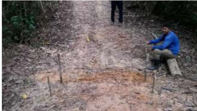
Figura 72 – Cravação de tocos para auxiliar no alinhamento
