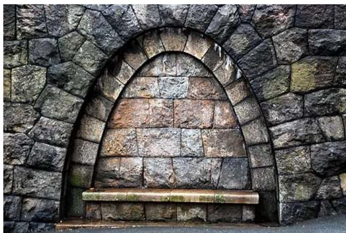
Figura 27 – Construção com Arco de Descarga
