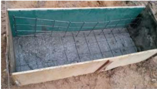
Figura 79 – Concreto magro e Malha de aço
