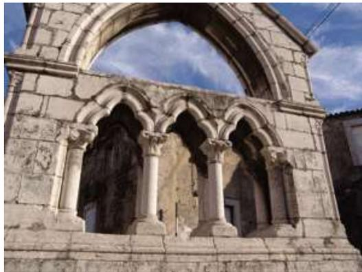
Figura 39 – Construção com Arco Trilobado
