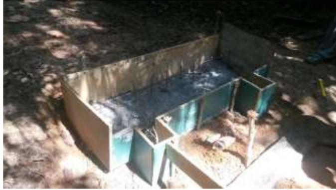
Figura 87 – Fôrma e concretagem do segundo bloco
