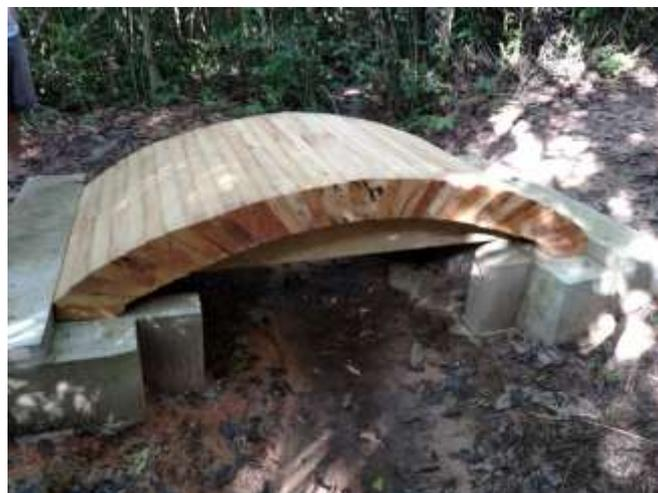
Figura 114 – Montagem completa da Ponte
