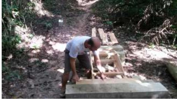
Figura 107 – Montagem das peças na fôrma
