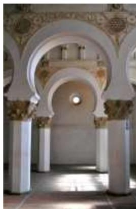
Figura 40 – Construção com Arco Ferradura
