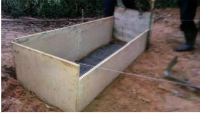
Figura 78 – Instalação das Fôrmas
