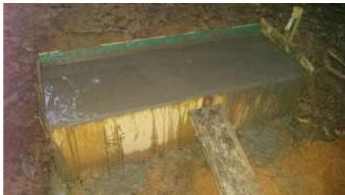
Figura 85 – Primeiro Bloco pós concretagem
