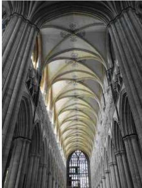
Figura 30 – Construção com Arco de Penetração e Arco de Ogiva
