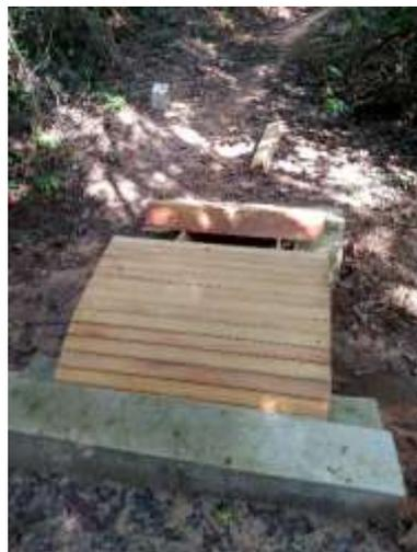
Figura 109 – Montagem das Peças na fôrma
