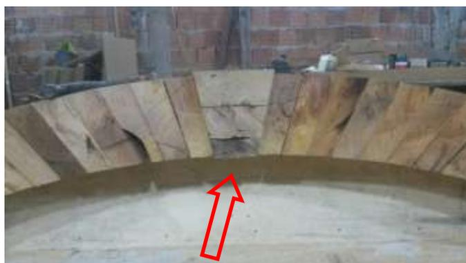
Figura 103 – Visualização da Peça chave na Estrutura
