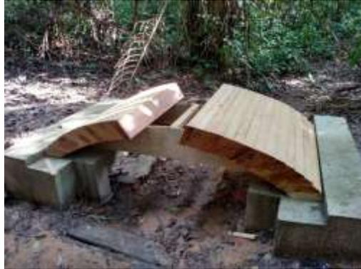
Figura 110 – Montagem das Peças na fôrma
