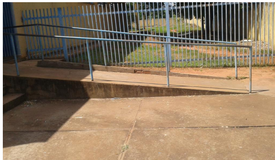
Figura 3.8: Rampa de acesso de uma escola.
