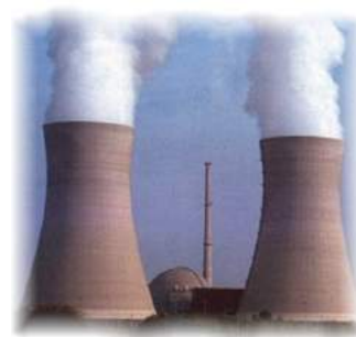
Figura 67: Torres hiperbólicas de superfície regrada em usinas Termonucleares - Fonte referência [17].
