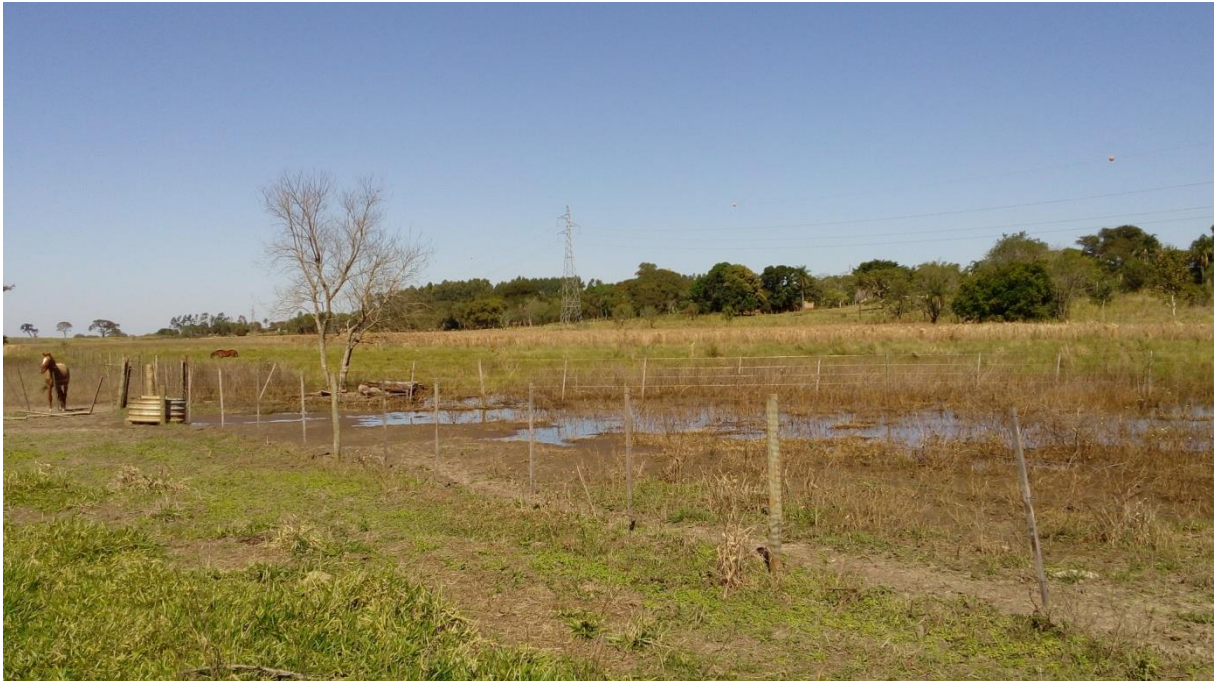
Imagem 4.2 - Fotografia da torre de transmissão de energia com obstáculo
