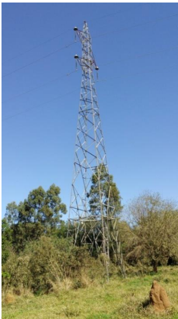
Imagem 4.1 - Fotografia da torre de transmissão de energia
