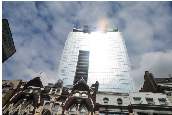
Figura 3.10: Prédio Walkie Talkie Ainda em Construção
