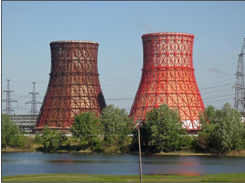
**Figura 3.6** - Aplicação do hiperboloide na Engenharia - Torre de resfriamento de usina nuclear.
