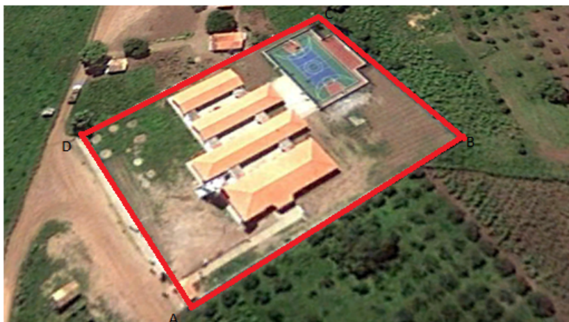
Figura 4.1: Vista aérea do Colégio Estadual Anativo do Sacramento. Fonte: Google Earth
