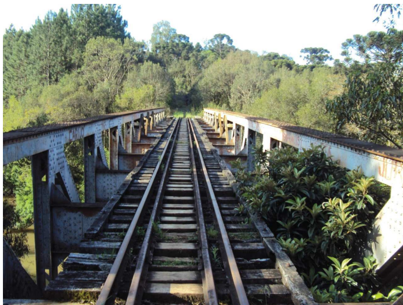
Figura 48: Ponte do “TEDESCO” (situação atual)
