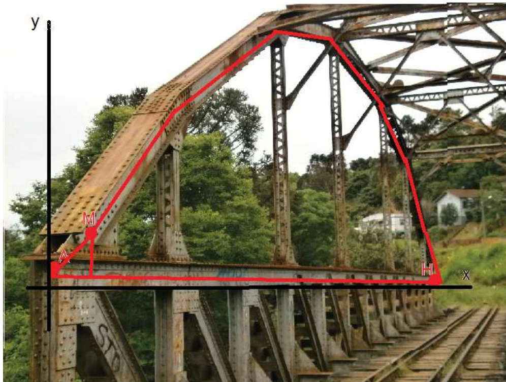
Figura 54: Pontos com coordenadas na ponte de ferro
