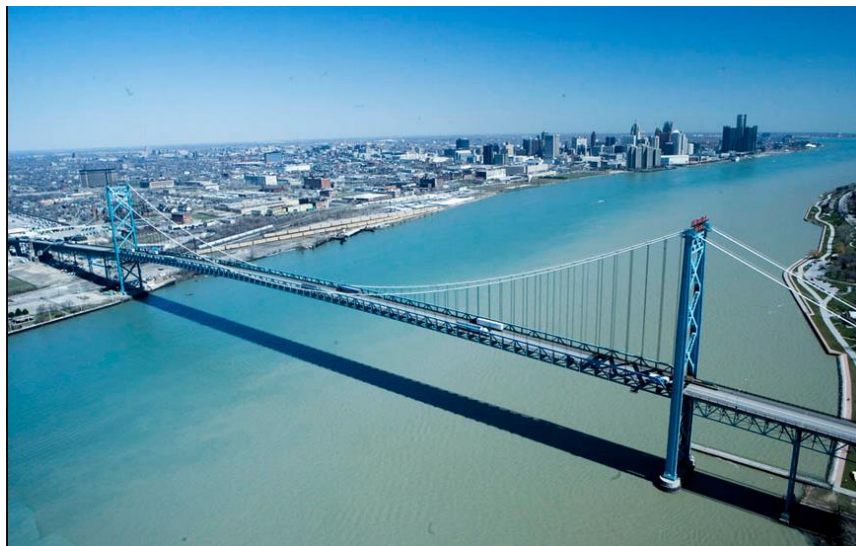
Figura 2 - Ponte Ambassador Bridge é uma ponte pênsil que ligas as cidades de Detroit- EUA e Windsor-CAN. Fonte: site megaengenharia.blogspot.com.
