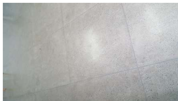
Figura 60: Piso da sala em malha
