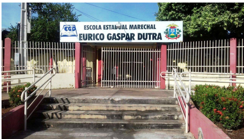
Figura 2.1: Escola Estadual Marechal Eurico Gaspar Dutra
