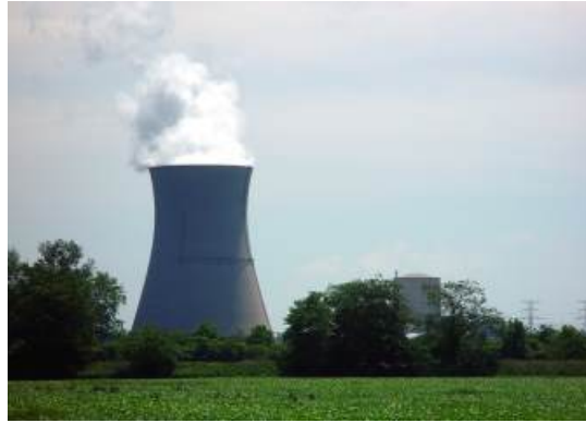
Figura 41: Torre de refrigeração.
