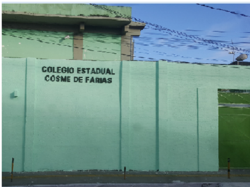
Figura 33 – Muro e fachada
