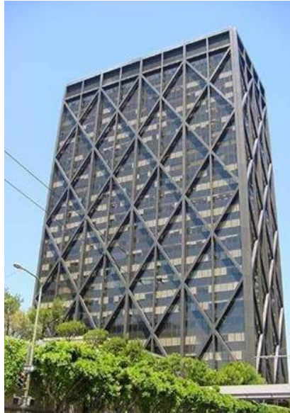
Figura 4.49: Edifício construído utilizando Braced Frameworks . Fonte: https://www.quora.com/What-are-the-advantages-and-disadvantages-of-braced-building .
