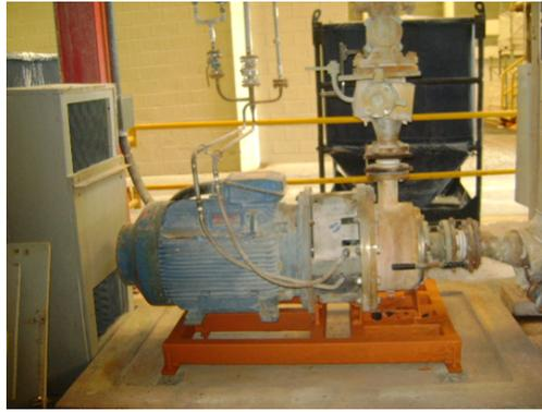
Figura 3.2: Bomba industrial instalada.
