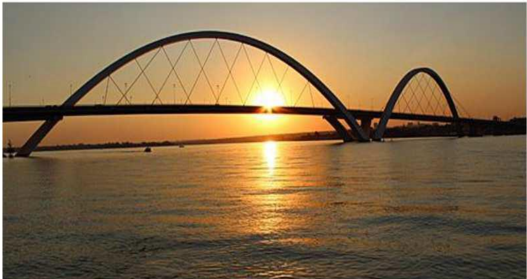
Figura 29 - Ponte Juscelino Kubitschek (Brasília/DF)
