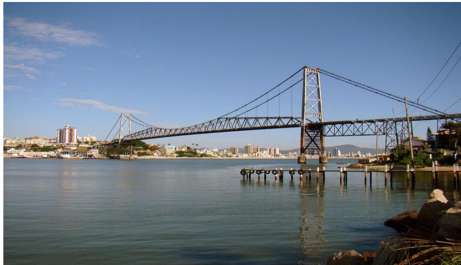
Figura 35 - Ponte Hercílio Luz
