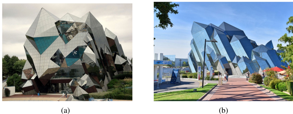
Figura 6 – Edifício do parque Futuroscope: (a) vista frontal; (b) vista lateral
