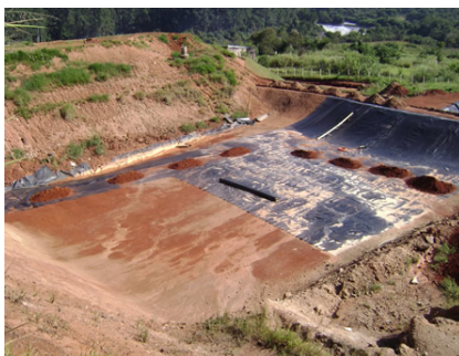
Aterro Sanitário em processo de construção
