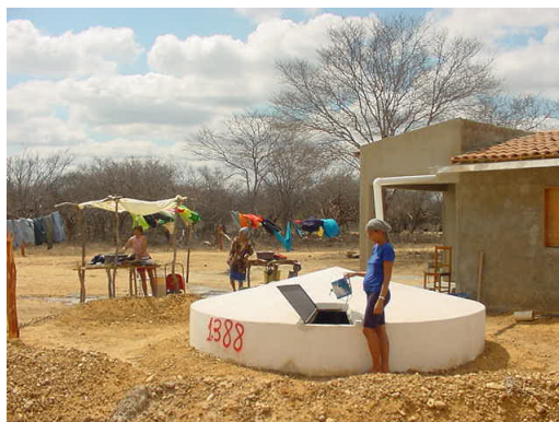
Cisterna para captação de água da chuva
