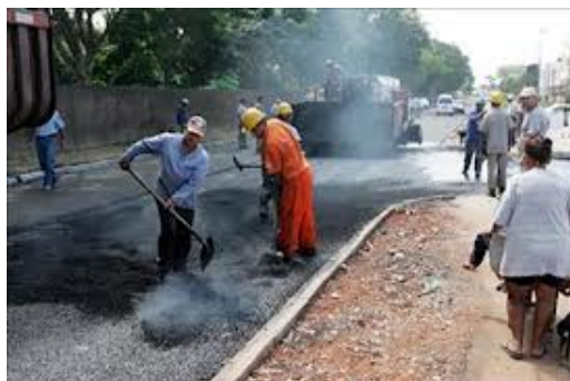
Obra de pavimentação asfáltica
