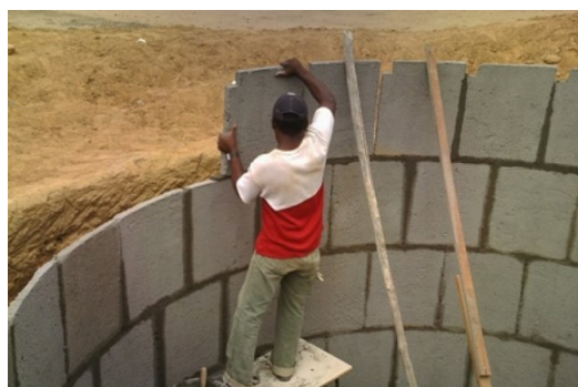
Construção de uma cisterna para captação de água da chuva
