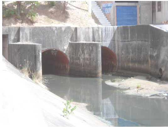
Canal de esgoto sanitário no formato de um cilindro
