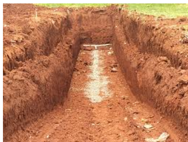
Vala de um Aterro Sanitário
