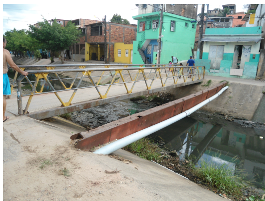
Pequena ponte ortogonal ao eixo de um canal de esgoto sanitário.
