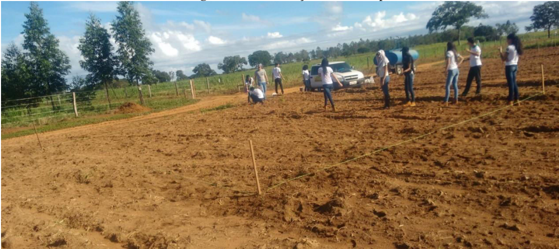
Figura 20 – Construção da área de plantio
