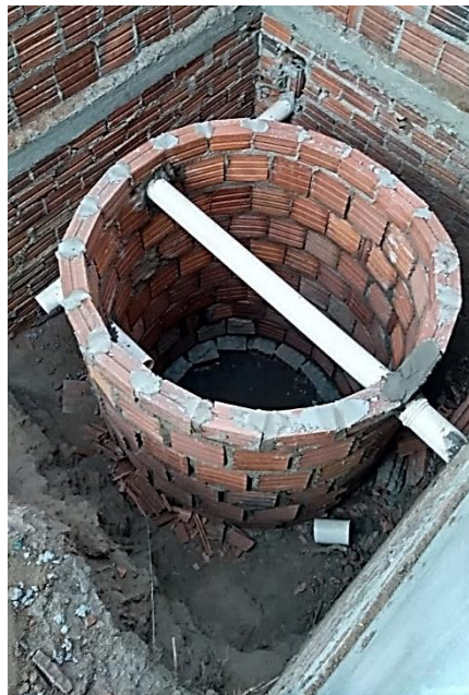
Figura 17 - Fossa séptica construída
