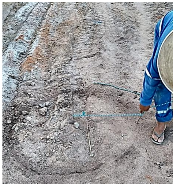
Figura 18 - Demarcação da área a ser construída
