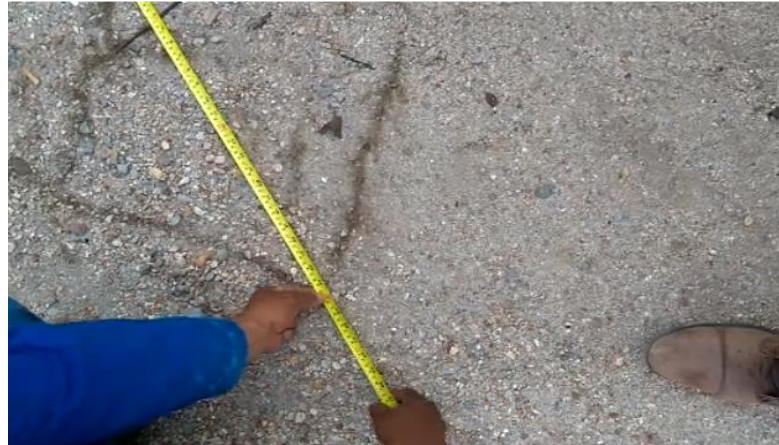
Figura 20 - Congruência de diagonais na verificação de esquadro
