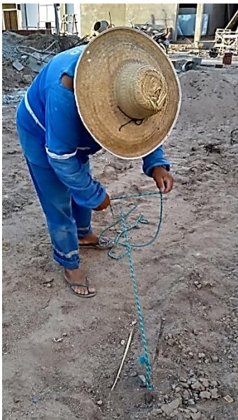
Figura 17 - Preparação para demarcação de fossa sanitária
