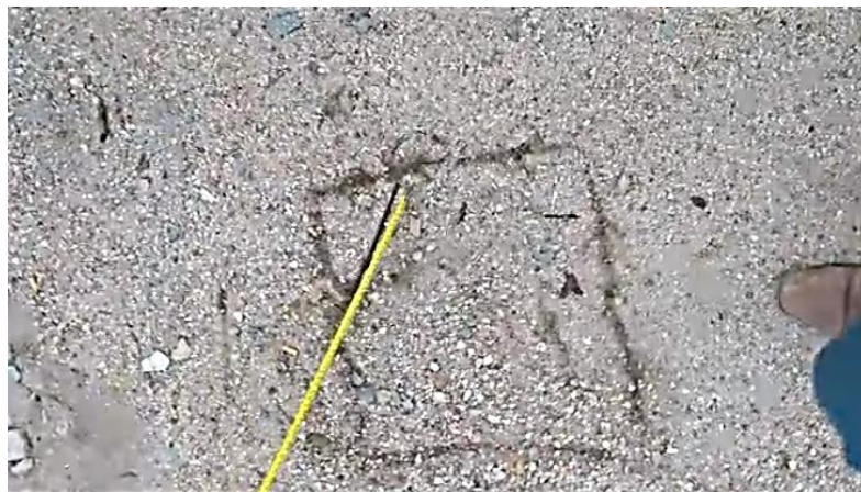
Figura 19 - Uso do teorema de Pitágoras na verificação de esquadro
