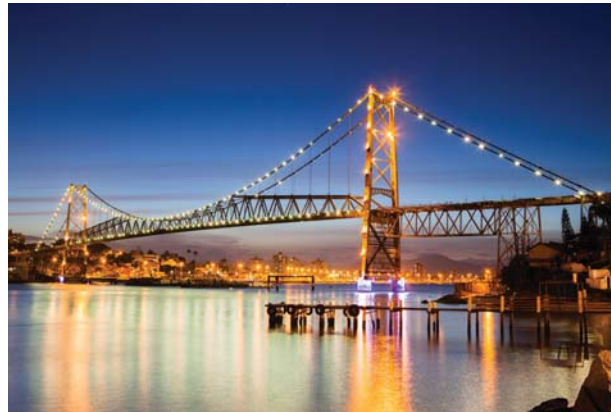
Figura 3.2: Ponte Hercílio Luz
