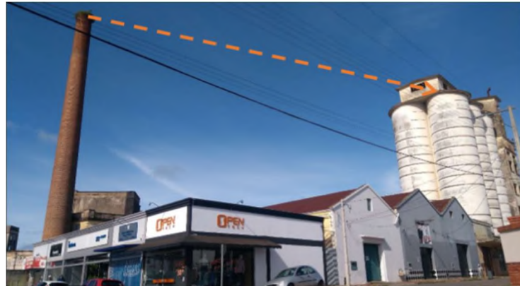
Figura 49 – Foto do Engenho Brasil e silo ao lado
