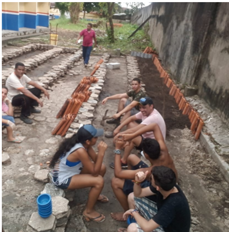
Figura 81 – Construção da horta escolar
