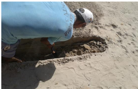
Imagem 9: Pedreiro cavando para construção do alicerce
