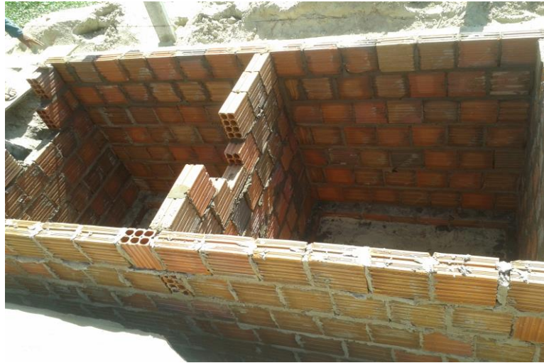
Imagem 26: construção da fossa
