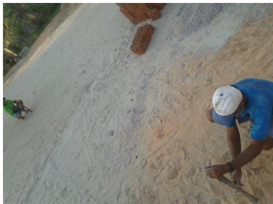
Imagem 7: Pedreiros retirando o nível da casa
