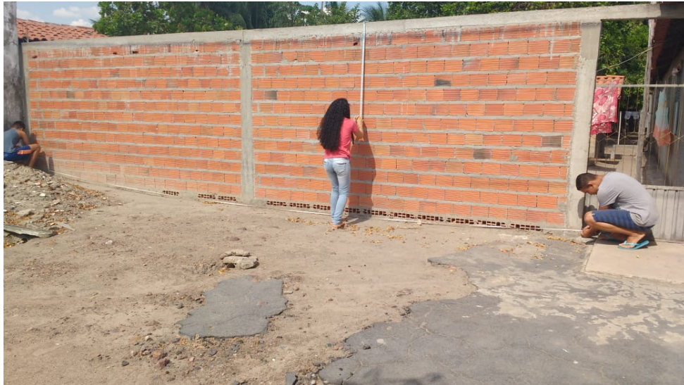
Figura 33: Muro Medindo 7.0m por 2.25m
