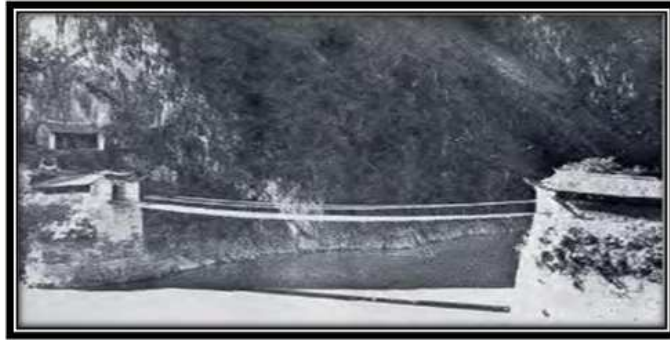
Figura 2.4: Ponte Quan–Xian, China.
