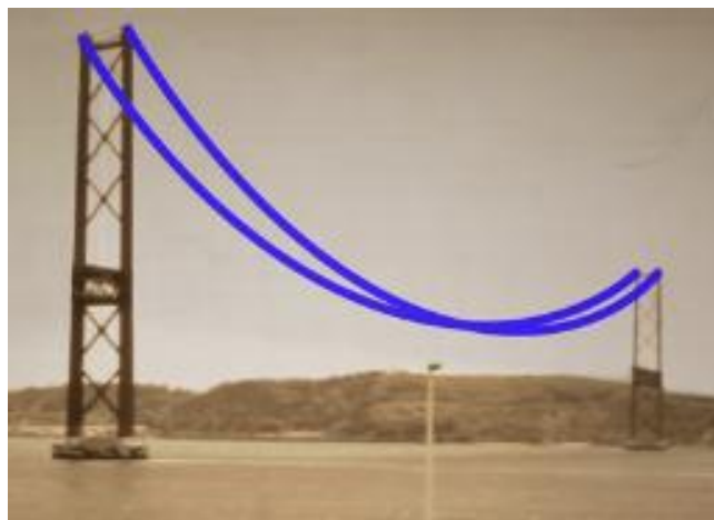
Figura 102 – Cabos suspensos em uma ponte pênsil em construção.
