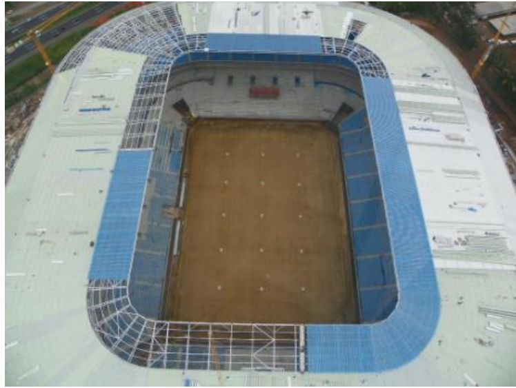
Figura 44 – Vista aérea da Arena do Grêmio
